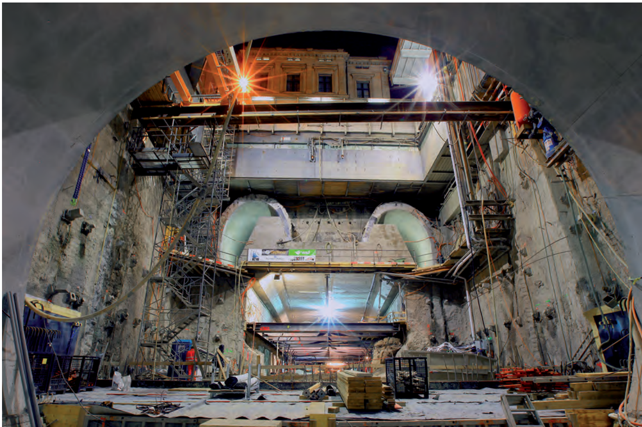
Puits, galeries et excavation sous la gare principale de Zurich (Pöyry)
